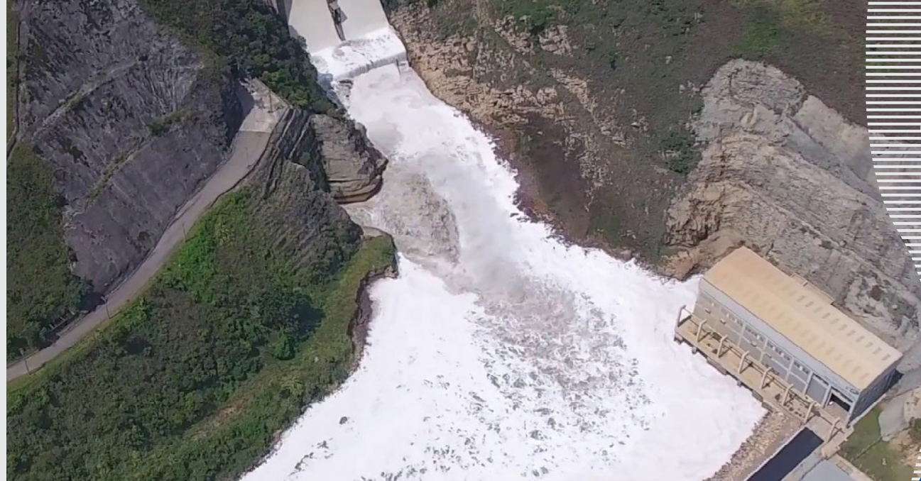
Vista aérea das estruturas da PCH Pirapora
