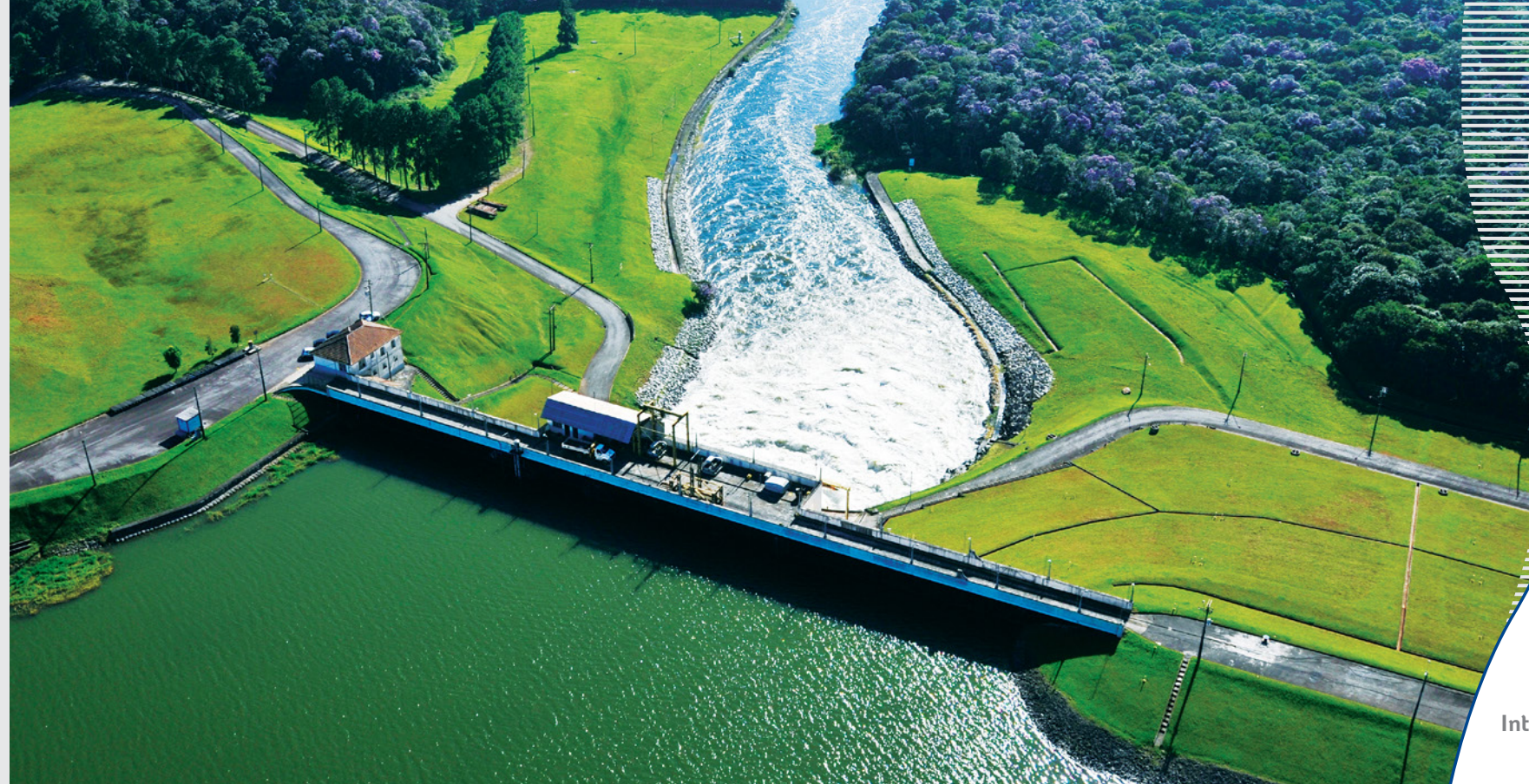
Barragem Rio das Pedras - São Bernardo do Campo/SP
